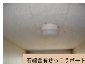
アスベスト含有建材の使用部位例
