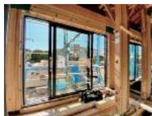
高性能樹脂サッシ取付
