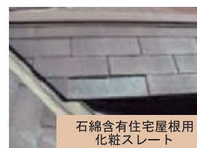
アスベスト含有建材の使用部位例
