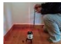
床の傾きを計測
