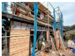
外壁通気工法化
